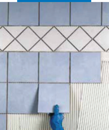
Укладка плитки ординарного обжига в качестве стенового покрытия в ванной поверх штукатурки
