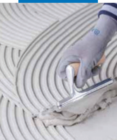
Укладка плитки ординарного обжига в качестве стенового покрытия поверх гипсовых панелей
