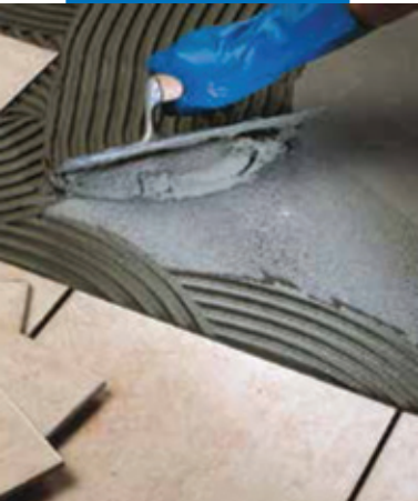
Укладка плитки ординарного обжига в качестве напольного покрытия
