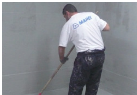
Нанесение Mapelastic Foundation валиком для гидроизоляции при эксплуатации с отрицательным давлением воды Нанесение Mapelastic
