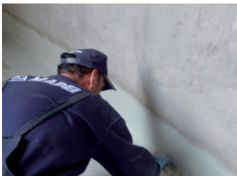
Нанесение Mapelastic Foundation шпателем для гидроизоляции при эксплуатации с отрицательным давлением воды
