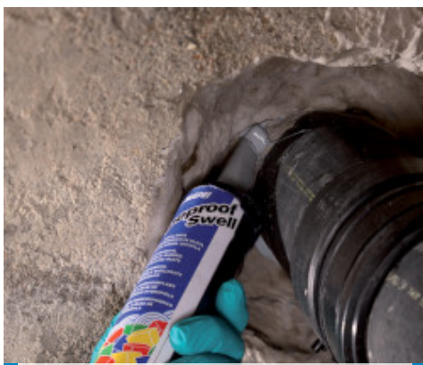
Герметизация элемента при помощи Maproof Swell
