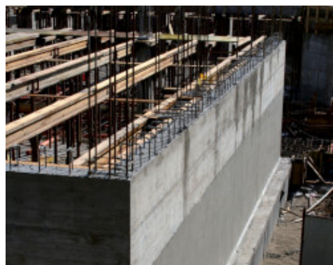
Нанесение гидроизоляции Mapelastic Foundation на подпорную стену после заливки
